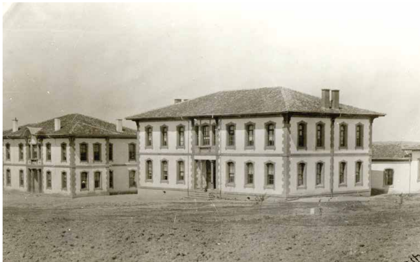
Bâtiment de l'orphelinat de Söğüt
